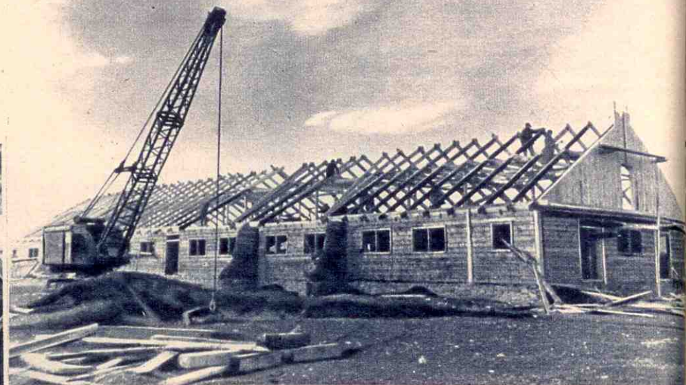
Осенью у строителей горячая пора. Новый свинарник и коровник надо построить до зимы.
